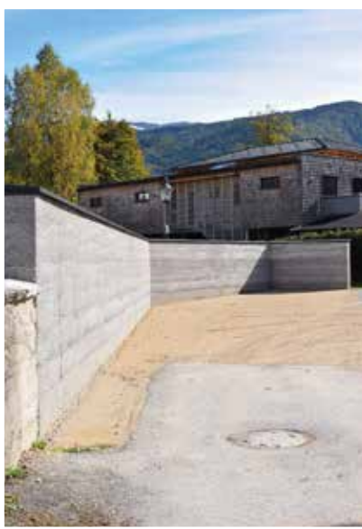
VERLÄNGERUNG DER FRIEDHOF SMAUER MIT EINER STAMPFBETONWAND
